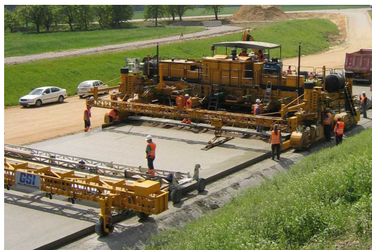
Рис. 1. Применение цементобетона при строительстве автомобильных дорог [1]
