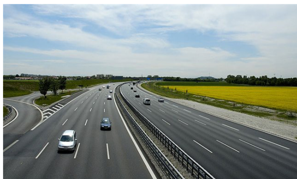
Рис. 2. Автомобильные дороги с цементобетонным покрытием [2]
