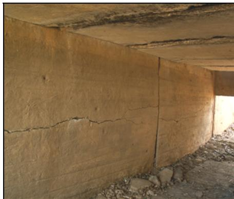
Рис. 3. Горизонтальные трещины в стенке моста
