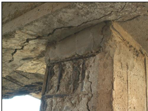
Рис. 2. Повреждения оголовка сваи и ростверка
