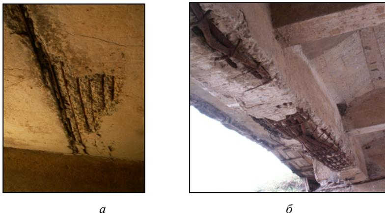
Рис. 5. Повреждения монолитных и сборных плит: *а* — разрушение защитного слоя; *б* — разрушение бетона монолитной плиты
