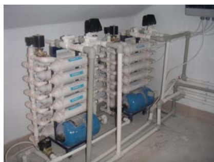
Рис. 1. Внешний вид (слева) и технологическая схема (справа) ультрафильтрационной установки для очистки горячей и холодной воды в жилых зданиях: 1 — шаровые краны для врезки в водопровод; 2 — сетчатый фильтр; 3 — магнитный клапан; 4 — ультрафильтрационные аппараты; 5 — напорный бак; 6 — реле давления
