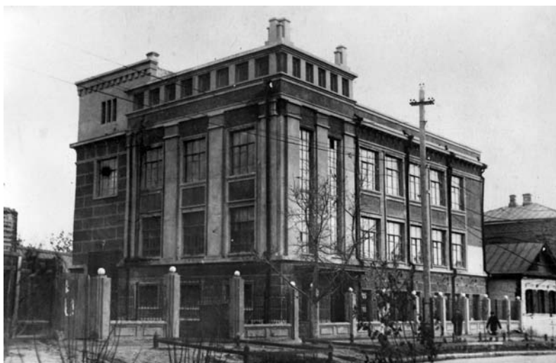
Рис. 4. Трамвайная подстанция на ул. Советской. Фото 1940 г.
