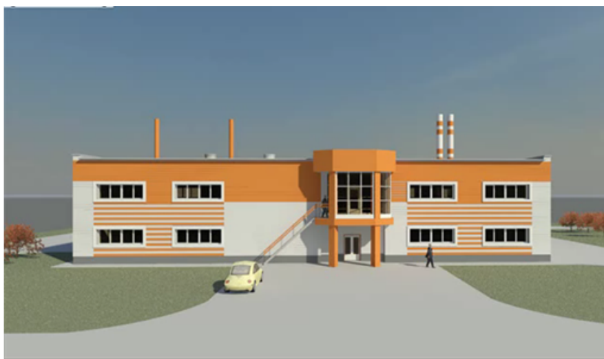
Рис. 14. Мини-ТЭС мощностью 1,5 МВт, работающая на биогазе
