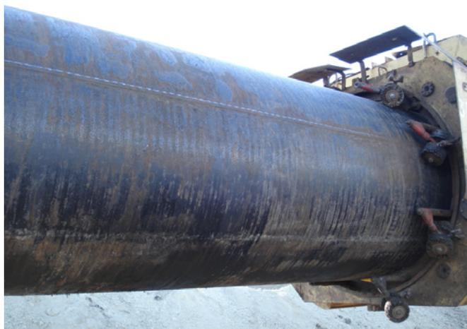
Рис. 5. Очистка трубы от изоляции при капитальном ремонте МТ
