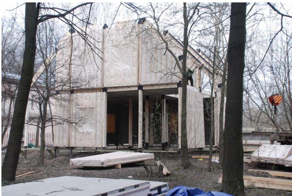
Рис. 3. Индивидуальный жилой дом в стадии сборки, выполненный в легких металлодеревянных каркасных конструкциях
